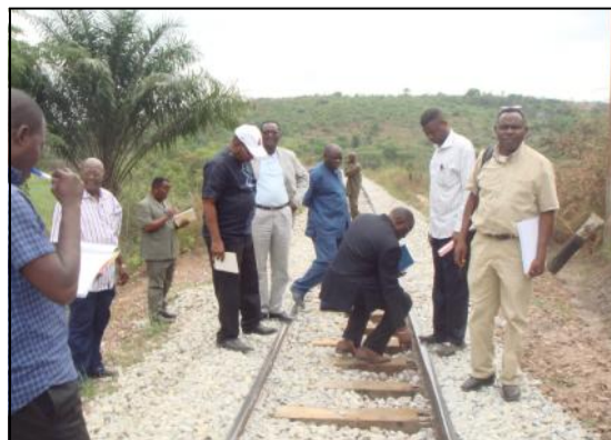
Le Cfcg a été réhabilité sur plusieurs kilomètres
