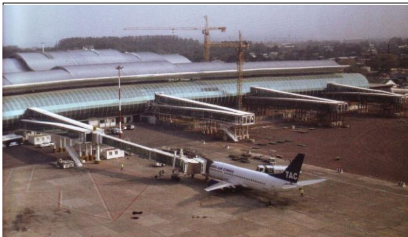
La nouvelle aérogare de Maya-Maya (Brazzaville)
