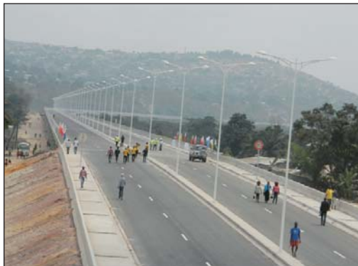
Les Congolais découvrent pour la 1 ère fois un viaduc
