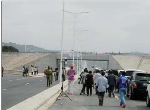
Un viaduc pour fluidifier la circulation à Brazzaville
