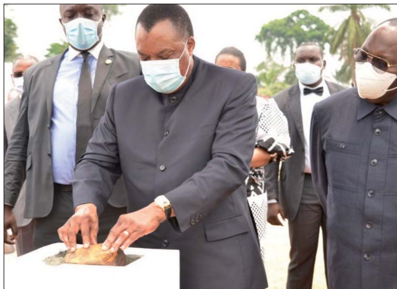
Coup d'envoi par le Président de la République des travaux de construction de la centrale électrique hybride thermique et photovoltaïque
